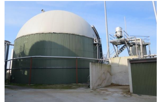
Feststoffseparation & Nachgärer
