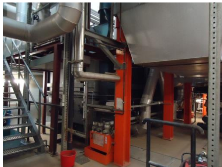
Flachschubrostfeuerung
